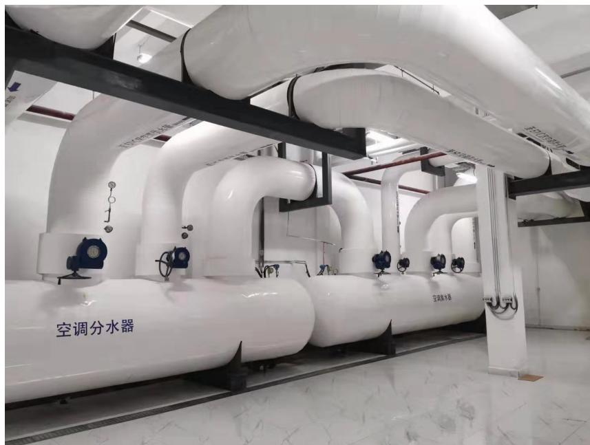
靓壳PVC彩壳[PVC彩壳保温外护系统俗称PVC外壳，是有成型PVC保温外护直管. 成型PVC保温外护弯头，成型PVC保温外护三通，成型PVC保温外护管帽等管件组成的保温层的外保护系统]PVC保温外护系统是一种新型质轻、光洁、耐候、耐腐蚀、阻燃持久耐用高性价比、符合美国农业部和食品药品管理局FDA的要求的管道及设备的保温外护系统产品，该产品为绝热层材料提供安装便捷、经济有效的保护。具有极好的抗雾霾、抗紫外线、抗老化、耐腐蚀和抗撕裂强度，属于难燃材料，适应于各种管道及设备的保温/保冷系列的外层保护。可替代各种传统金属外保护材料。
